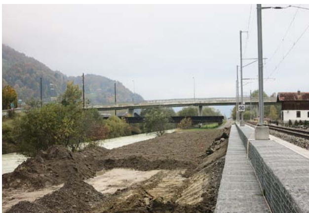
Bauarbeiten im Raum Stägmatten
