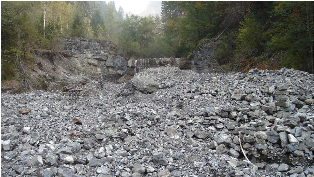
Im Bachbett des Lammbachs (wie hier bei Sperre Ia) lagern grosse Geschiebemengen.
