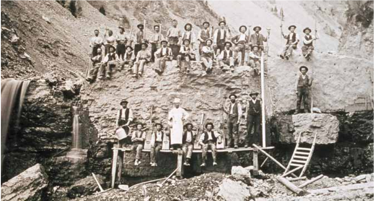
Bau der Sperre Nr. 1 (Baubeginn Herbst 1896).
