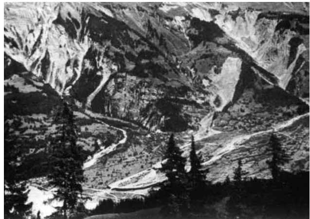
Die bereits vollendeten Umfassungsdämme von Lamm- und Schwanderbach.
