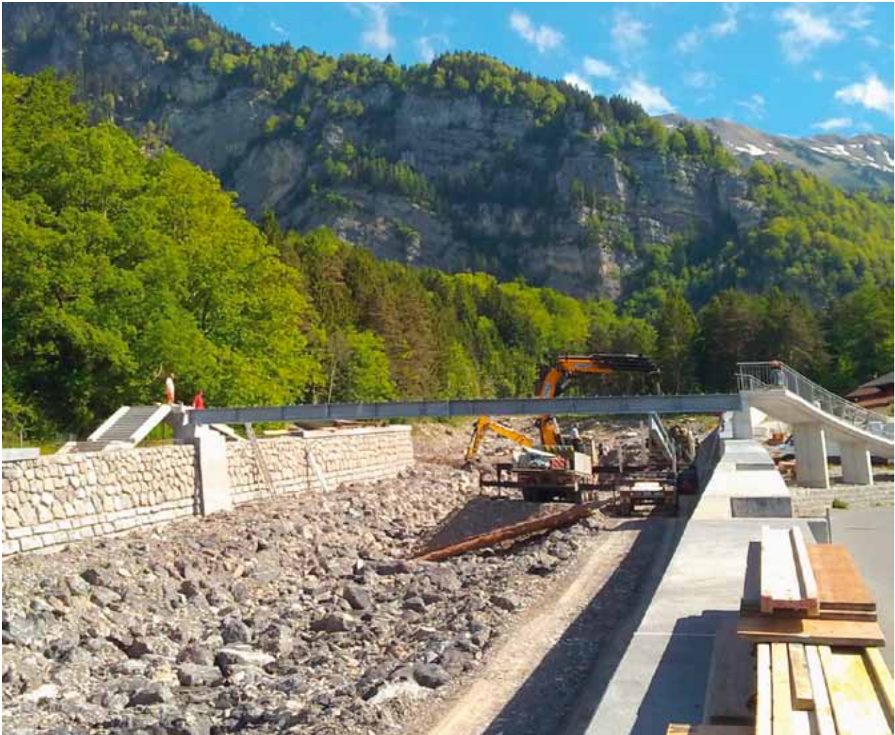
Montage der Stahlträger für den Fussgängersteg
