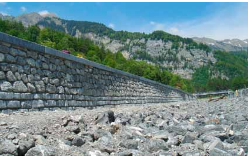
Das Raubettgerinne und die westliche Schutzmauer
