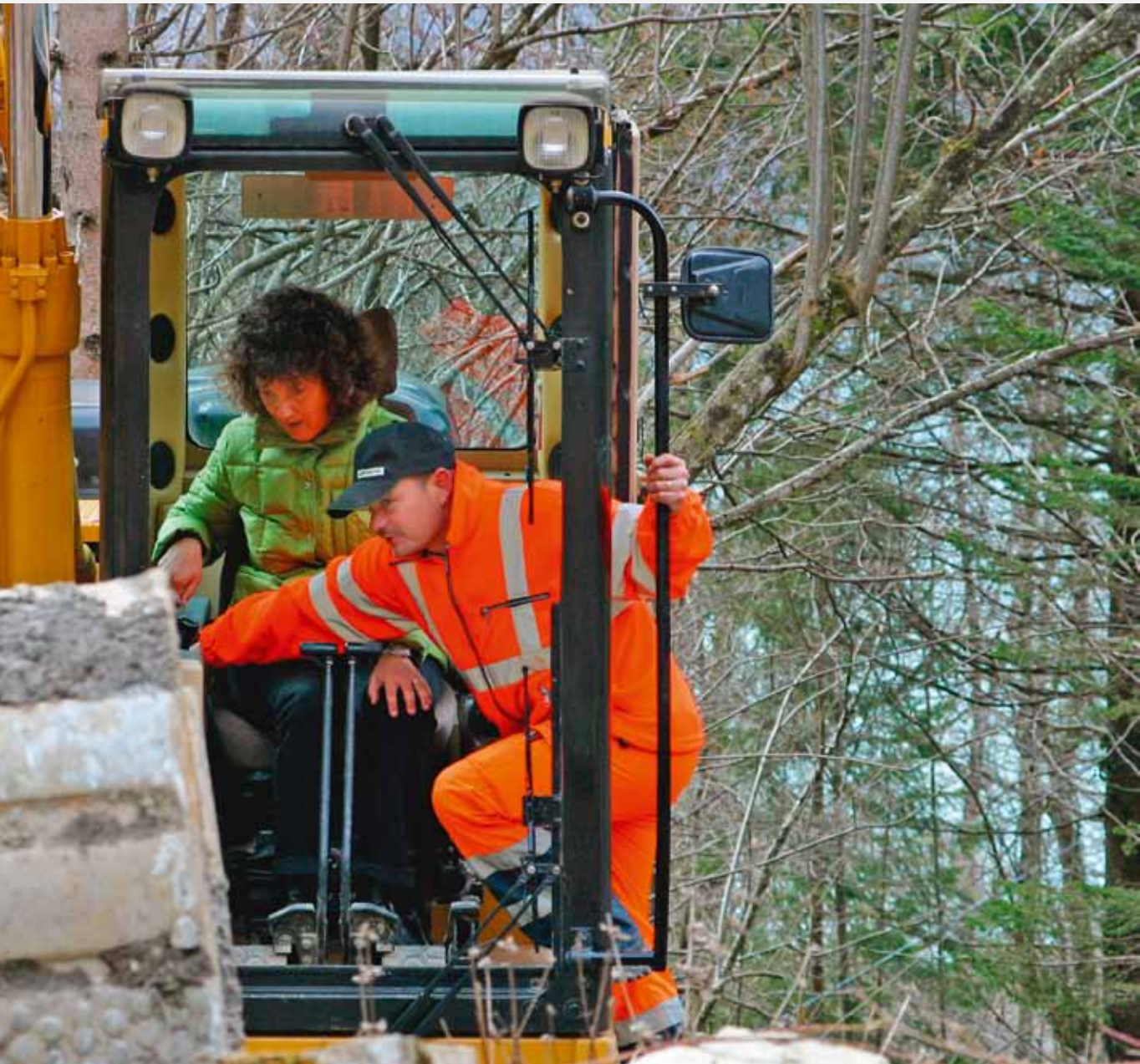
Mit Unterstützung von Maschinenführer Hanspeter Schmid setzte Regierungsrätin Barbara Egger-Jenzer am 13. März 2008 beim Glyssibach zum Spatenstich an. (Archivbild Beat Kohler, Jungfrau-Zeitung)
