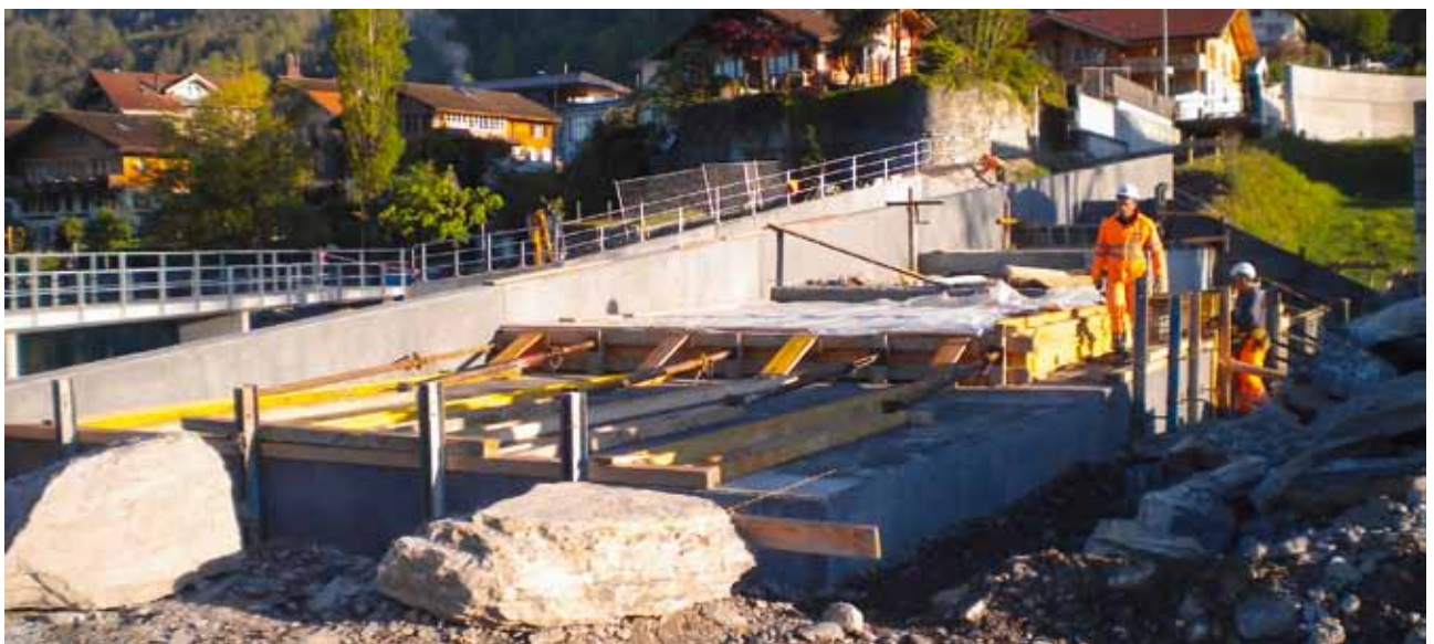
Bauarbeiten an den Sitzelementen auf dem Cholplatz
