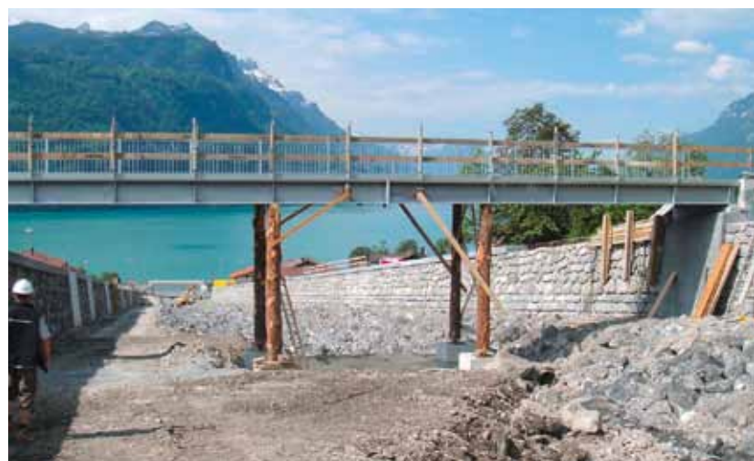
Unterspierung der Fussgängerbrücke vor dem Einbau des Überbetons
