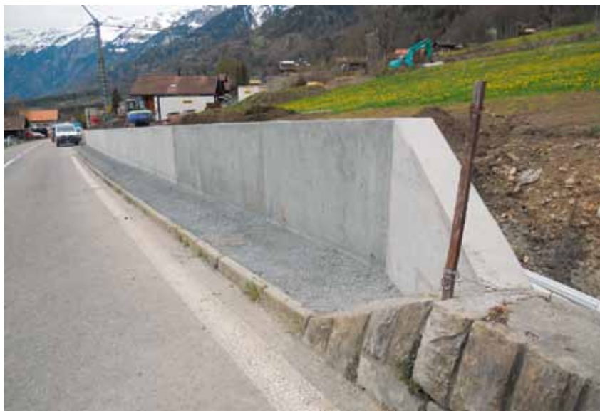
Überlastmauer entlang der Brünigstrasse
