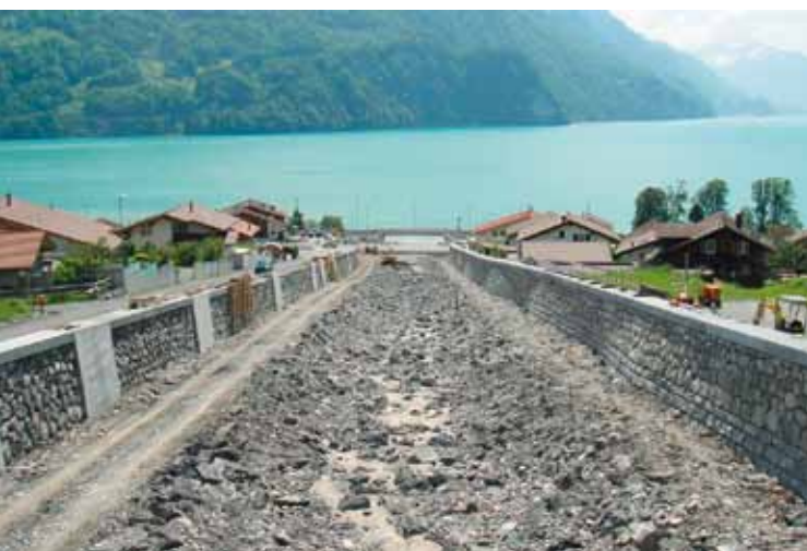
Blick vom neuen Fussgängersteg in den Abflusskorridor
