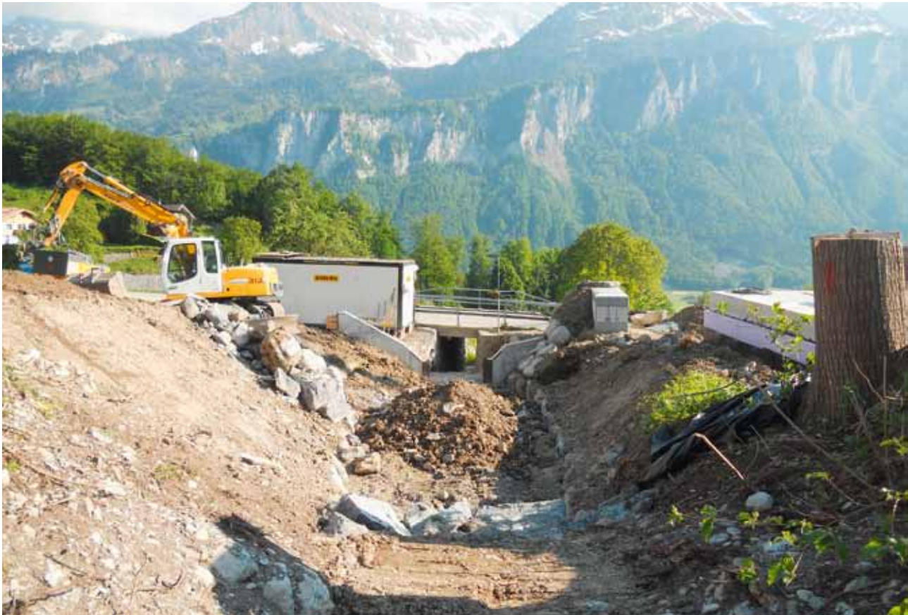
Beim Geschiebesammler an der Brünigstrasse wird das Becken gestaltet; die Sperre bei der Brücke ist bereits betoniert
