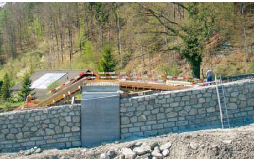
Rampe und Treppe auf der Westseite der neuen Fussgängerbrücke beim Schwandergässli im Bau
