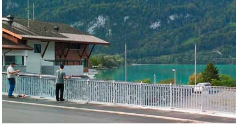
Montage des Brückengeländers.
