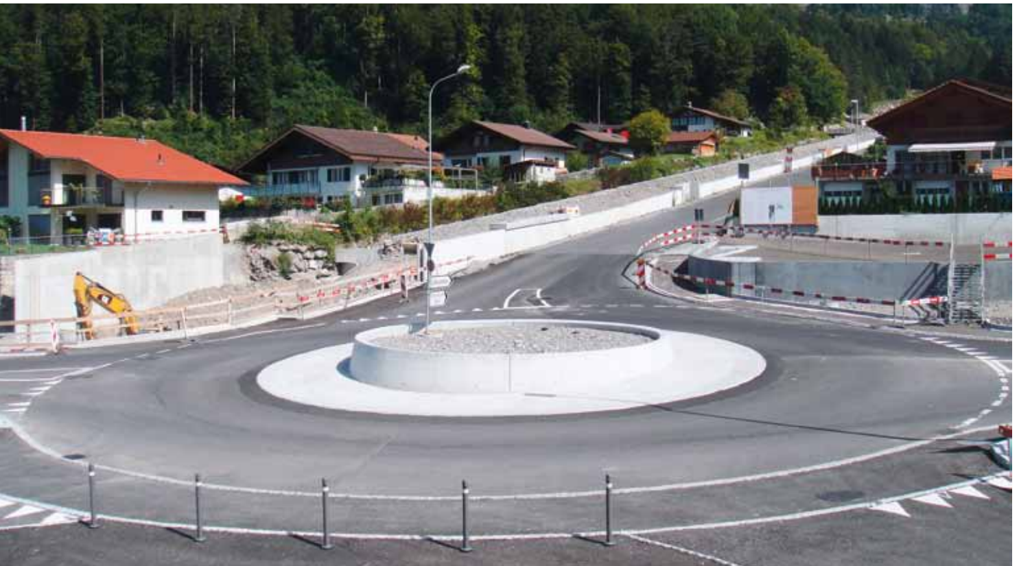
Die neue Kreiselanlage kurz nach ihrer Fertigstellung.
