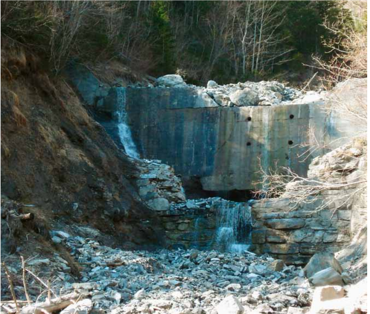
Eine der alten Betonsperren oberhalb des Ausleitbauwerks.
