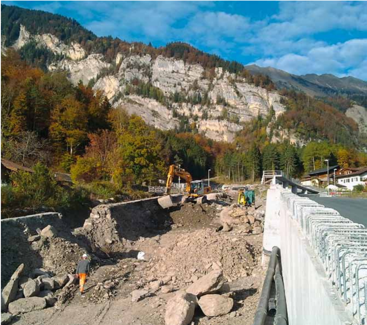
Abbruch der alten Bachschale.
