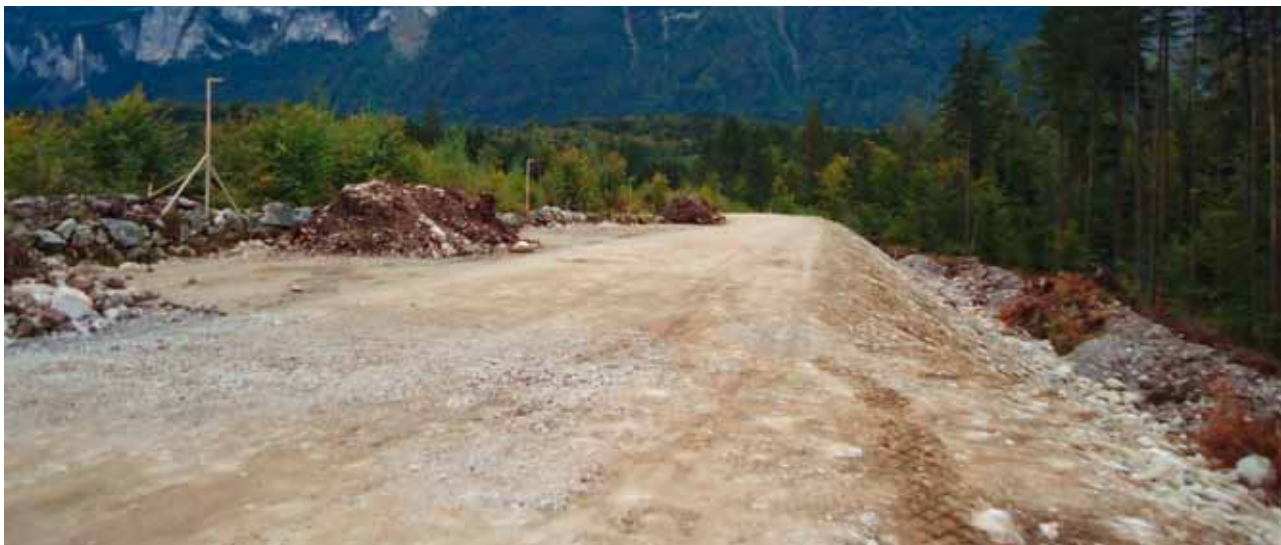
Anfang September 2011: Der Schutzdamm in Etappe 1.2 nimmt bereits Gestalt an.
