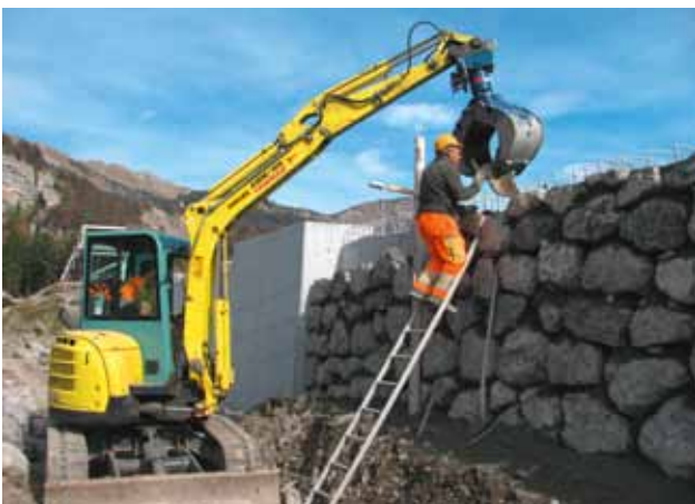
Bachseitige Vormauerung mit Natursteinblöcken aus der alten Bachschale.
