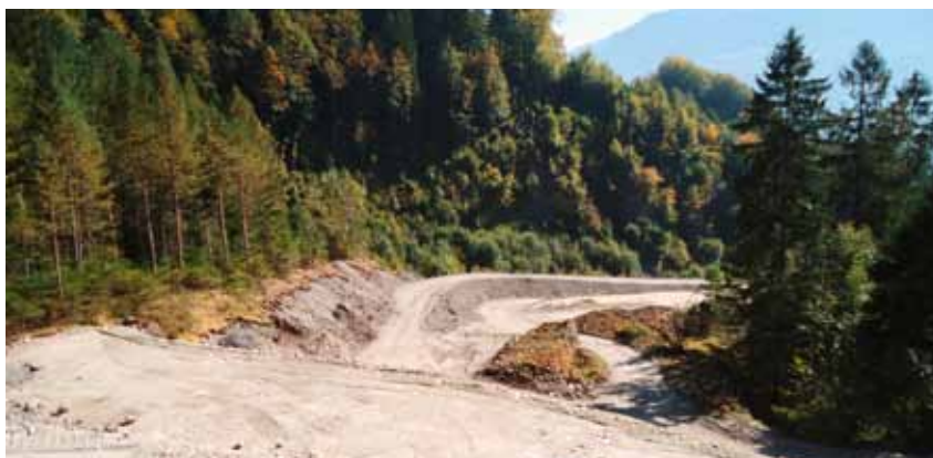
Anfang Oktober 2011: Die Schüttung auf dem obersten Abschnitt erreicht langsam die definitive Höhe des neuen Damms.
