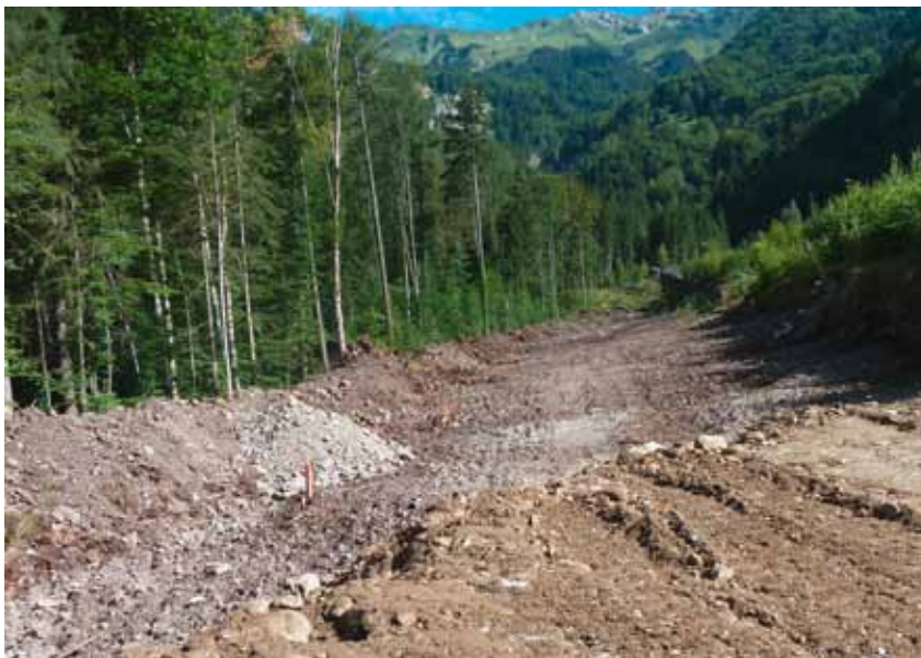
Mitte August 2011: Die Etappe 1.2 ist gerodet, der Waldboden abgetragen und erstes Material zum Bau des Hochwasserschutzdamms eingebaut.
