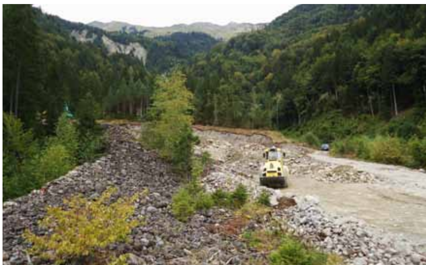
September 2011: Erstes Material aus Innertkirchen wird in die Etappe 1.1 eingebaut.
