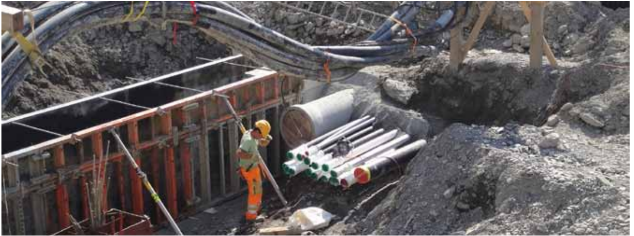
Rohrblock für die Querung der Werkleitungen unter dem Glyssibach-Gerinne
