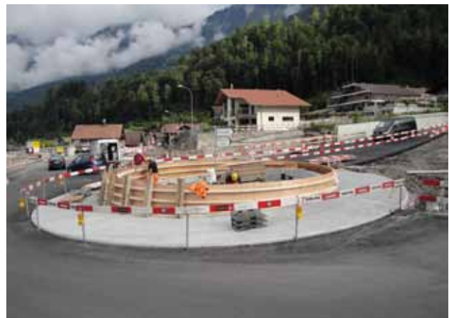
Schalung des Kreisels
