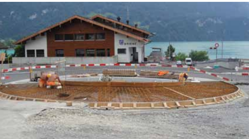
Der Schwerlaststreifen im Kreisel wird armiert
