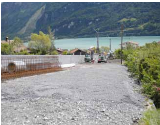
Eingebrachter Schotterrasen und neue Parkplätze am neuen Steineggliweg.
