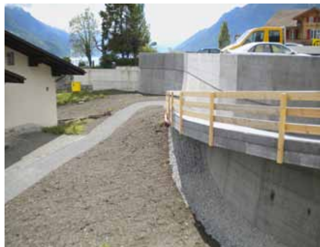
Neuer Weg und angepasstes Terrain entlang der Stützmauer unterhalb der Hauptstrasse.
