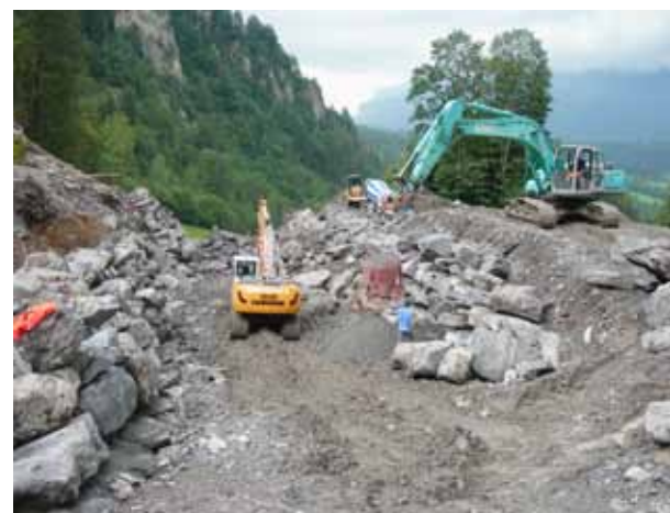
Beim Überleitgerinne werden Böschungsböcke in Hinterbeton versetzt.
