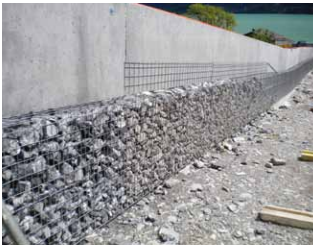
Entlang der Leitmauer hat die Füllung der Steinkörbe begonnen.
