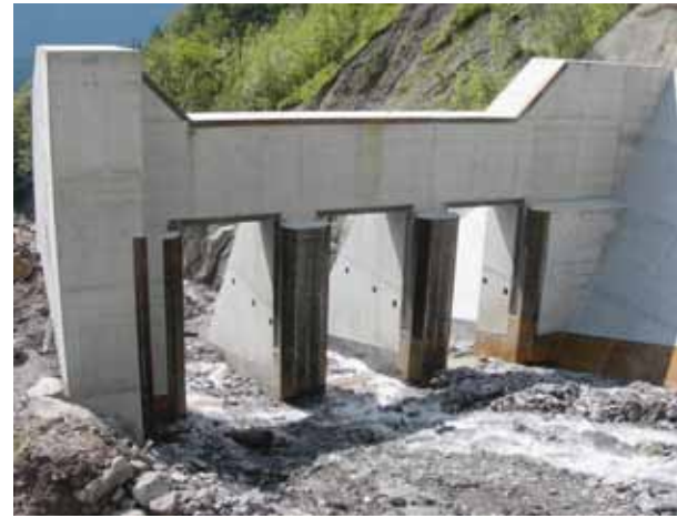
Oben: Auf der Nordseite ist das Ausleitbauwerk mit Stahlblechen ausgestattet.
