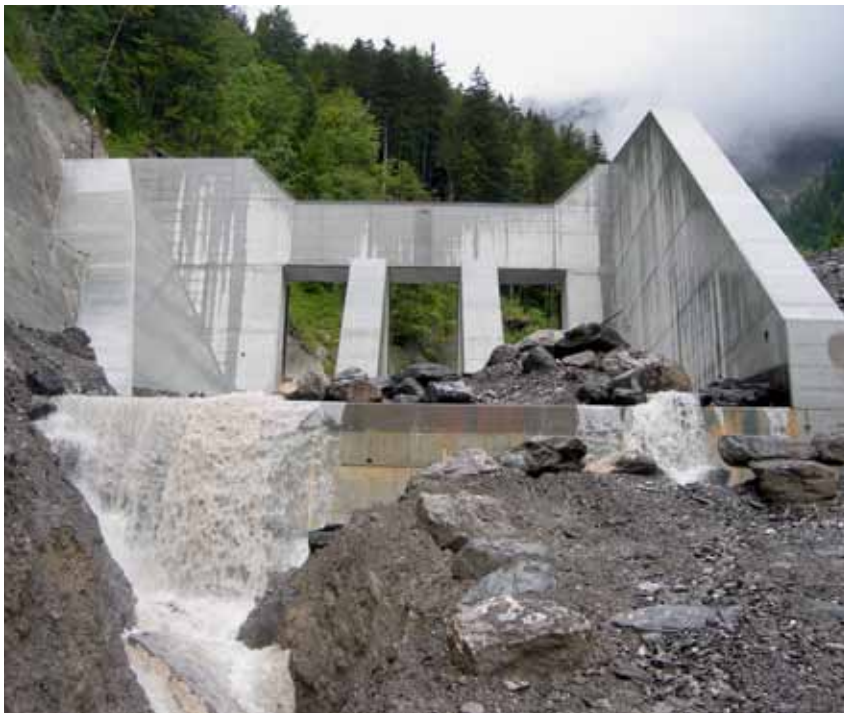
Südseite des Ausleitbauwerks.
