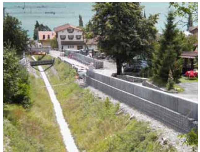
Leitmauer am Steineggliweg. Der alte Steineggliweg wird zurzeit noch als Zufahrtsstrasse benutzt.
